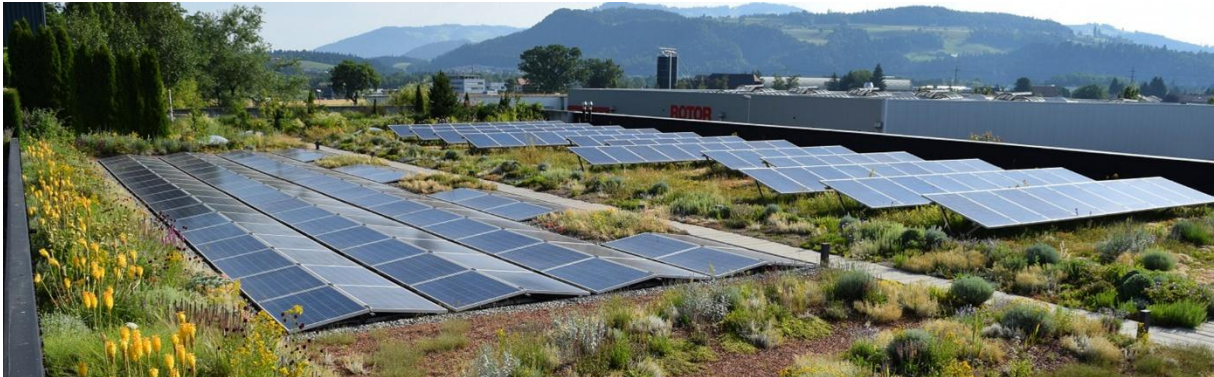
Abbildung 5: Flachdach mit PV-Aufständerung und Dachbegrünung
