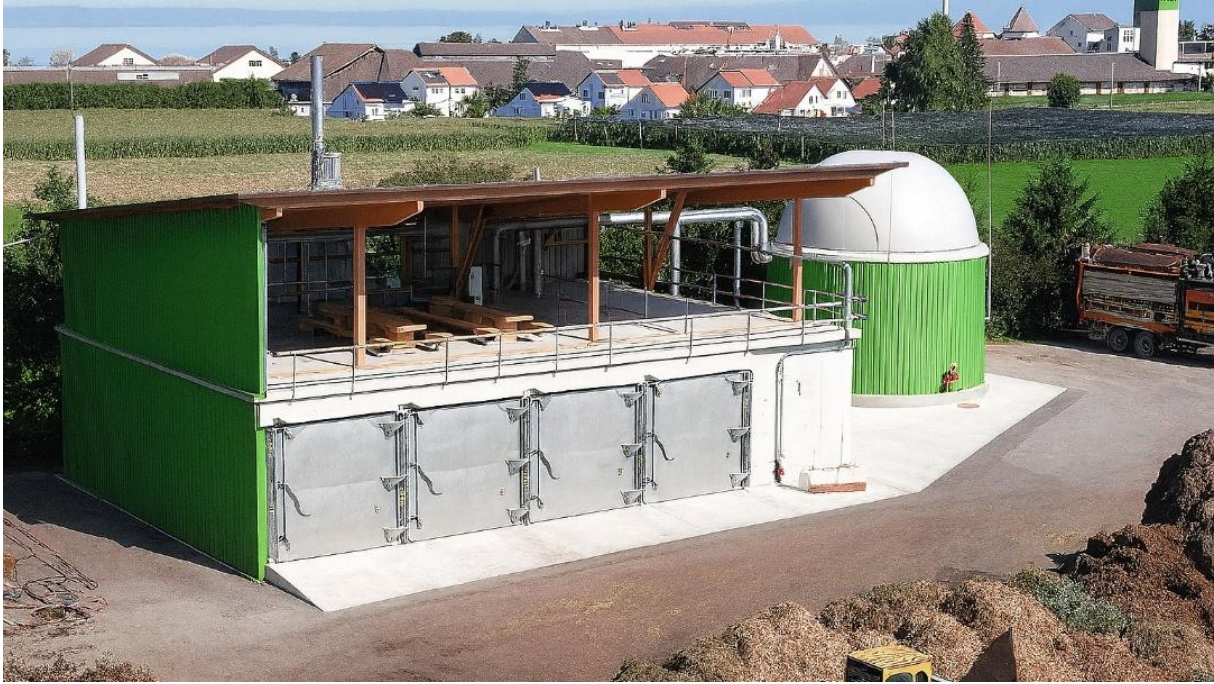
Abbildung 11: Nassvergärungsanlage Renergon RSD-S
